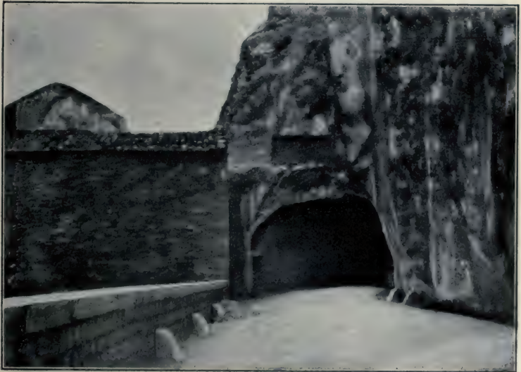
39. Eingang in einen Tunnel der Via flaminia (Passo del Furlo bei Rimini).
